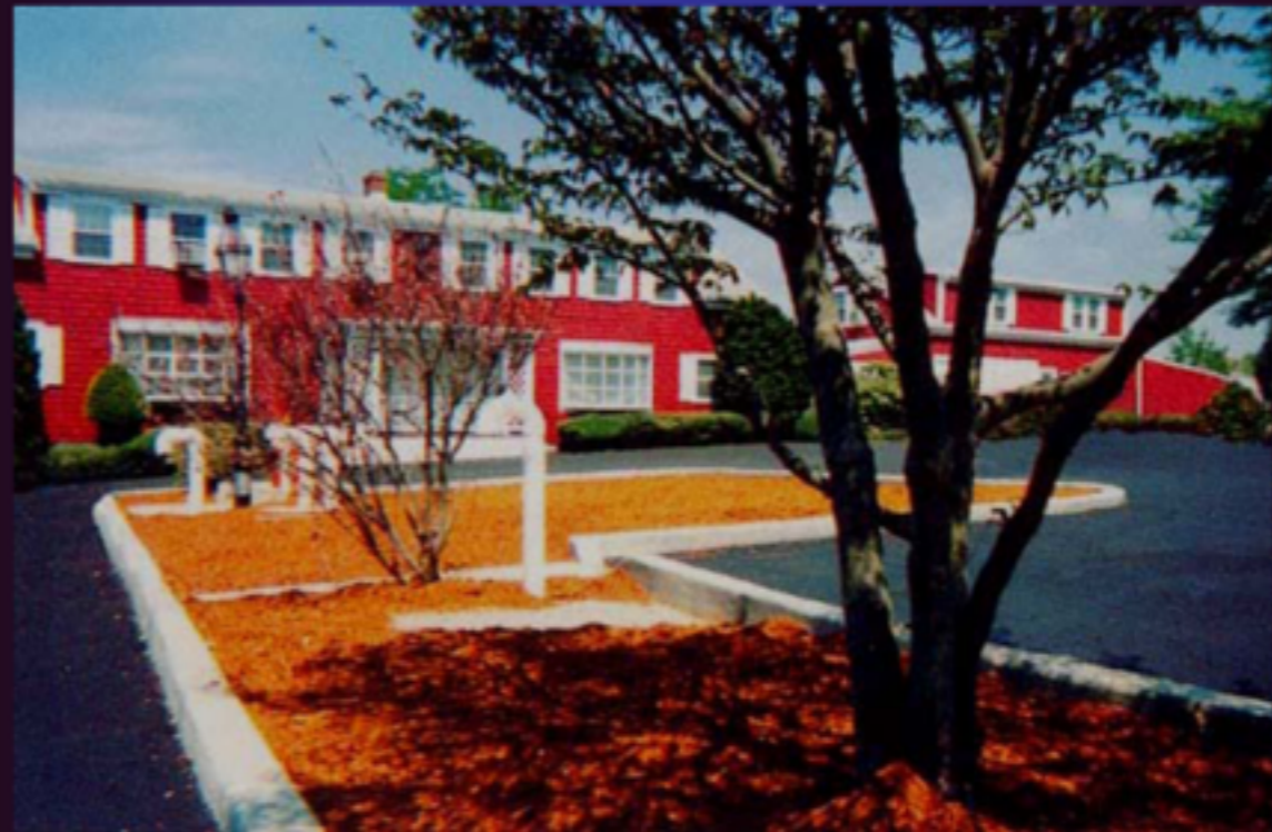
Sistema FAST completo en operación
